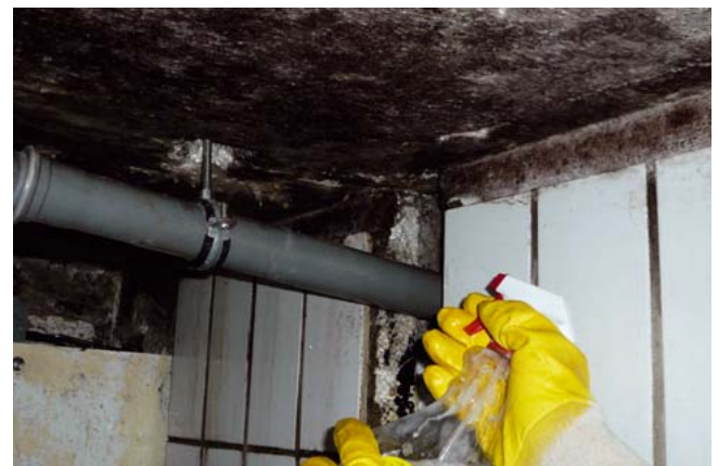
Schimmelbehandlung mit INTRASIT® SE Sanierlösung an schwer zugänglichen Stellen mittels Sprühflasche
