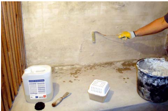
Untergrundvorbehandlung zur Sporenbindung mit INTRASIT® SE Sporenbinder
