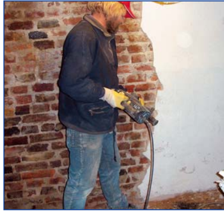
2 Salzbelasteten Putz vollständig entfernen. Losen Fugenmörtel auskratzen.
