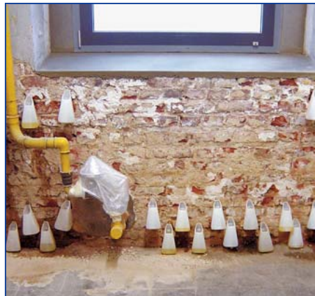
5 Bohrlöcher vornässen. INTRASIT® Verkieselung oder INTRASIT® MEK/-BLK über die Bohrlöcher in den Wandquerschnitt bringen. Nach Beendigung der Injektarbeiten die Bohrlöcher mit INTRASIT® Bohrlochsuspension verfüllen.
