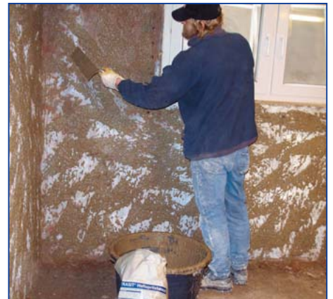
6 Im Feuchtigkeitsbereich (oder ganzflächig) INTRASIT® Dichtschlämme/-DS 1 und INTRASIT® Verkieselung im Wechsel zweimalig aufbringen. Anschließend einen Haftspritzbewurf aus INTRASIT® Vorspritz WTA netzartig deckend auftragen.
