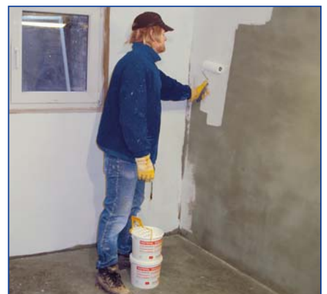
9 Die Schlussbeschichtung der Sanierputzoberfläche kann ausschließlich mit dampf-offenen Systemen erfolgen. Als Anstrich VESTEROL® Silikatfarbe verwenden.
