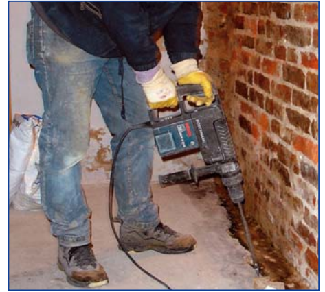
3 Zum Wandanschluss hin vorhandenen Estrich bis zu einer Breite von 30 cm entfernen.
